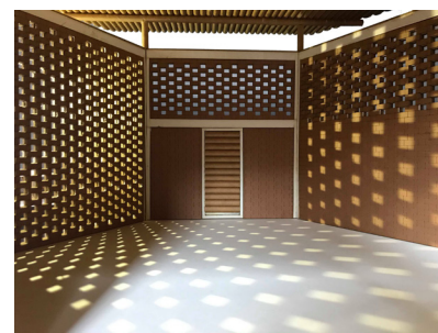
BRIQUES MOUCHARABIEH LAISSANT PÉNÉTRER LA LUMIÈRE
