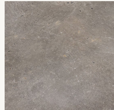
BÉTON POLI (EXISTANT)
