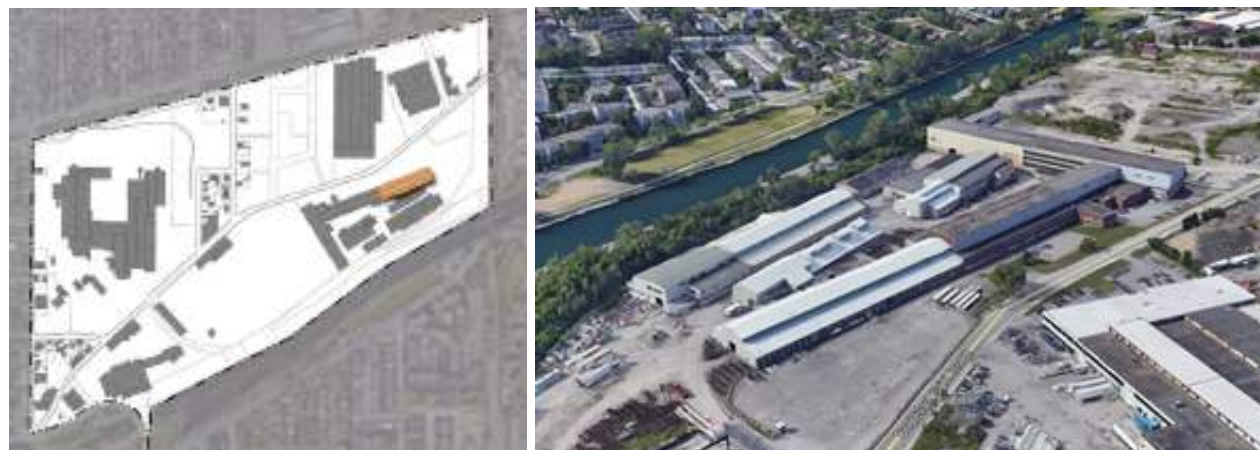
Figure 6: Emplacement et photo d'Allis Chalmers (Google Earth, 2020)
