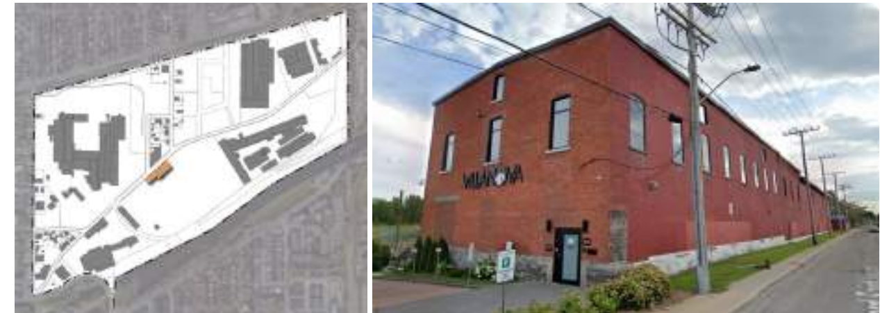
Figure 7: Emplacement et photo de Stelfil (Google Maps, 2020)
