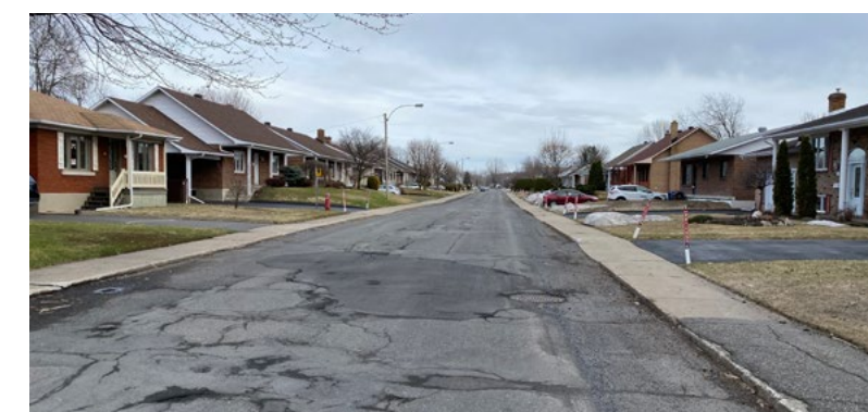
Figure 40. Vue de la rue Barthe, Sorel-Tracy. Source : Marc-Antoine Gauthier, 2020.
