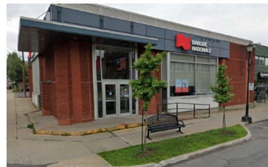
Figure 36. Mobilier urbain en saison estivale, centre-ville de Sorel-Tracy. Source : Google Street View, 2019.
