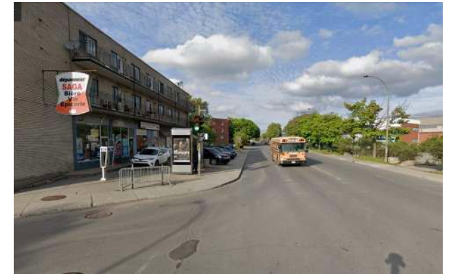
AMÉNAGEMENT ACTUEL DU DOMAINE PUBLIC D'UNE TÊTE D'ÎLOT À WESTHAVEN
