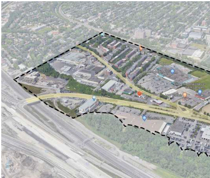
VUE AÉRIENNE DE L'INTERSECTION ACTUELLE BOULEVARD SAINTE-ANNE DE BELLEVUE/ RUE SAINT-JACQUES
