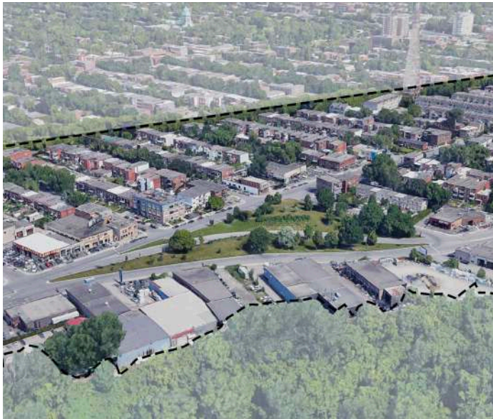
VUE AÉRIENNE DE L'INTERSECTION ACTUELLE CHEMIN UPPER-LACHINE/ RUE SAINT-JACQUES
